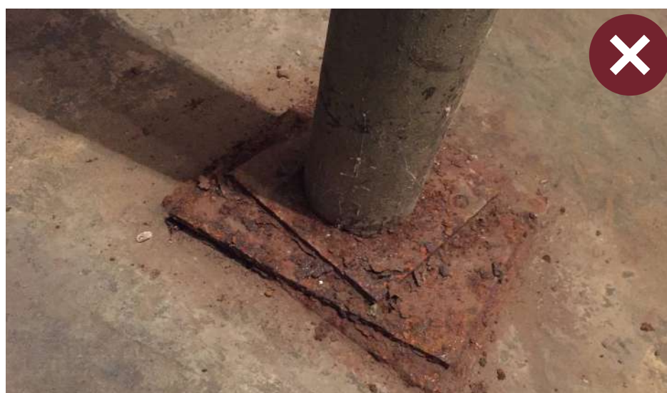
الشكل ٢,٣٩: صدأ قاعدة عمود هيكل المظلة
